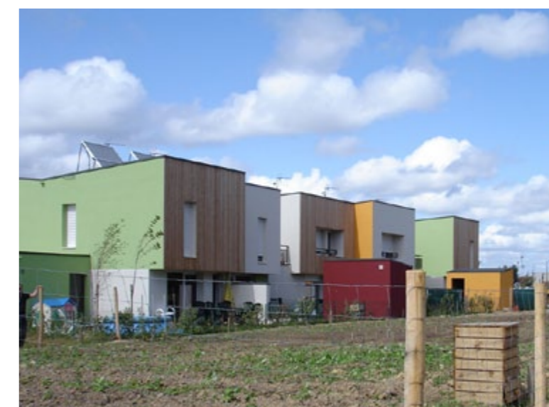
Utilisation ponctuelle de couleurs vives et d'un bardage bois ZAC de la Grand Ouche, Bouguenais (44) architectes : Sophie Blanchet
