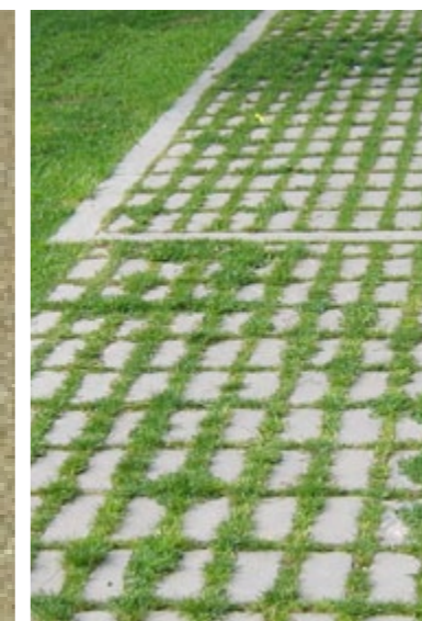
(De gauche à droite) Bandes béton et engazonnement * Béton désactivé * Pavés béton joints enherbés * Briques rouges creuses
