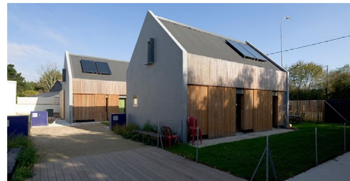
Exemple de panneaux solaires, calepinés sur toiture double pente Treillières (44) architectes : Jacques Boucheton architectes
