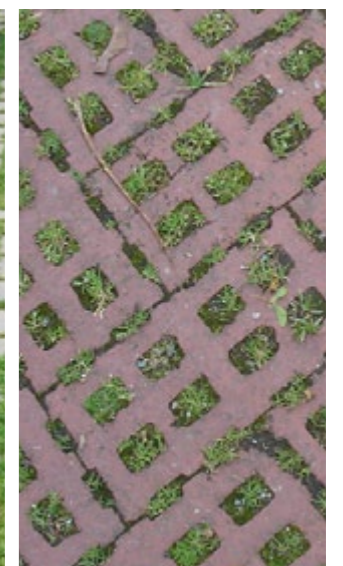
(De gauche à droite) Bandes béton et engazonnement * Béton désactivé * Pavés béton joints enherbés * Briques rouges creuses
