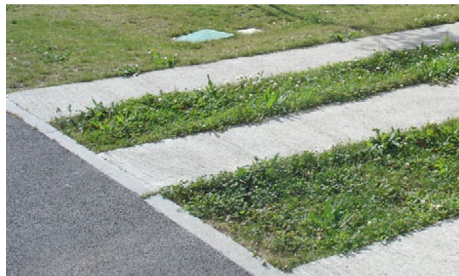
(De gauche à droite) Bandes béton et engazonnement * Béton désactivé * Pavés béton joints enherbés * Briques rouges creuses
