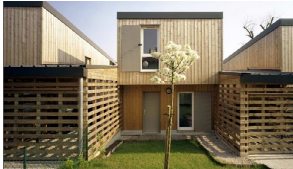
Box de stationnement en bois ajouré (à gauche)
